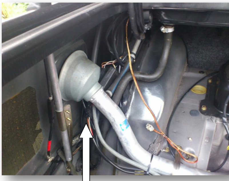
Steckverbindung für Stromversorgung der Vorförderpumpe
